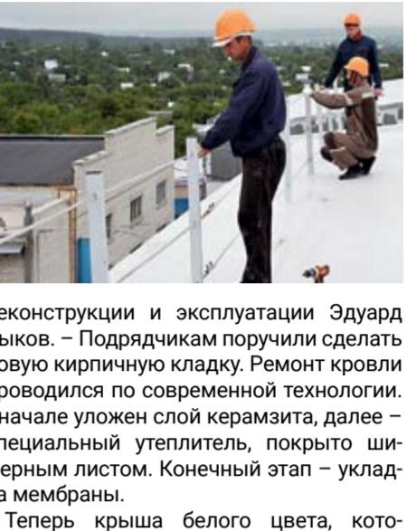
реконструкции и эксплуатации Эдуард Быков. – Подрядчикам поручили сделать новую кирпичную кладку. Ремонт кровли проводился по современным технологиям. Вначале уложен слой керамзита, далее – специальный утеплитель, покрыто шиферным листом. Конечный этап – укладка мембрани.
